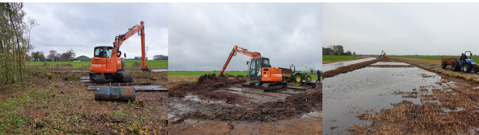
Links: met de kraan worden de stobben gerooid. Midden: de kraan haalt 25 cm van de toplaag van de bodem weg en schept het direct in de trekker, zodat het plagsel meteen wordt afgevoerd. Rechts: zoals gebruikelijk staat er een laag water op het afgeplagde deel.
