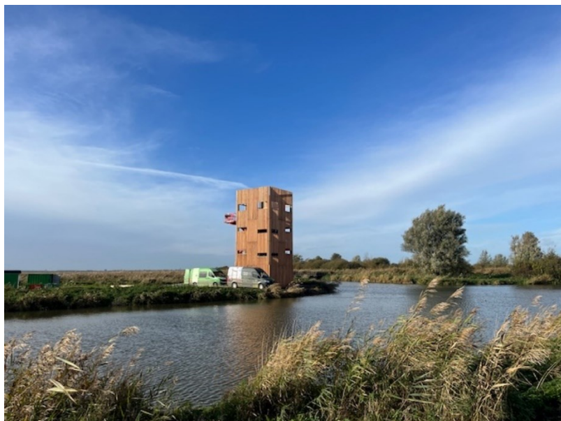
Figuur 4.9 Een nieuwe uitkijktoren verrijst in de noordelijke punt van de Driehoek
