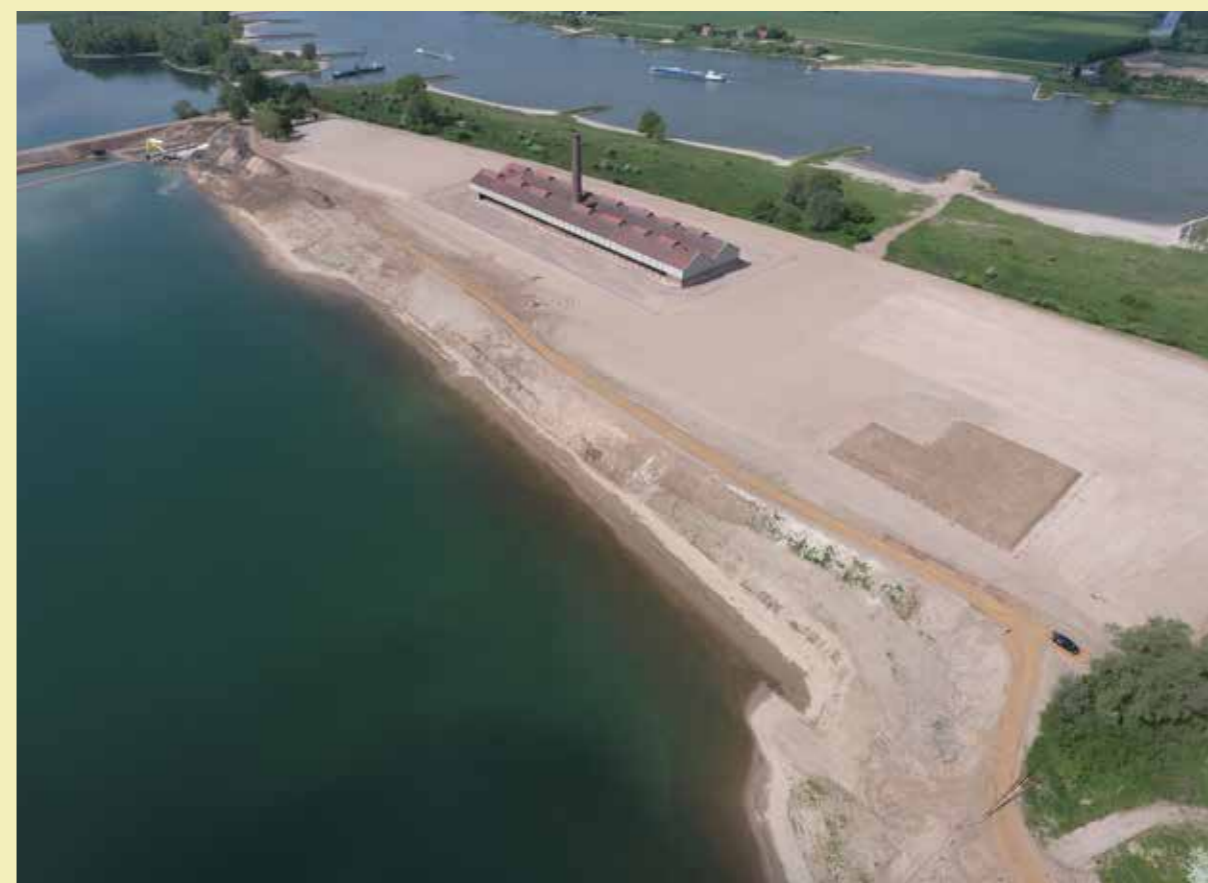
Hoogwatervluchtplaats en geul – na sanering | Bureau Meet BV - Heteren
