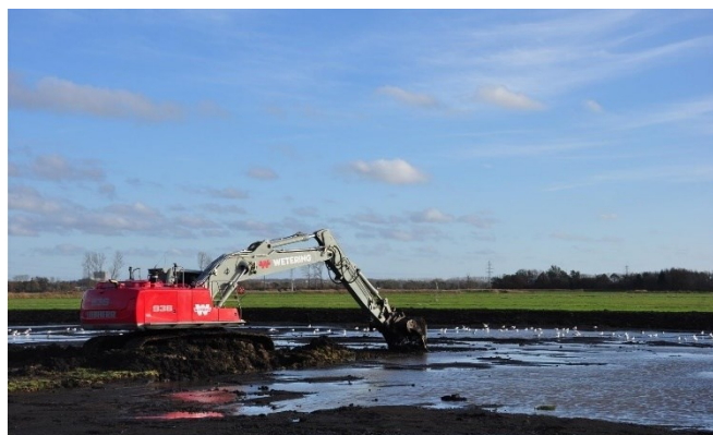
Foto: Graafmachines gaan verder met het plaggen.
