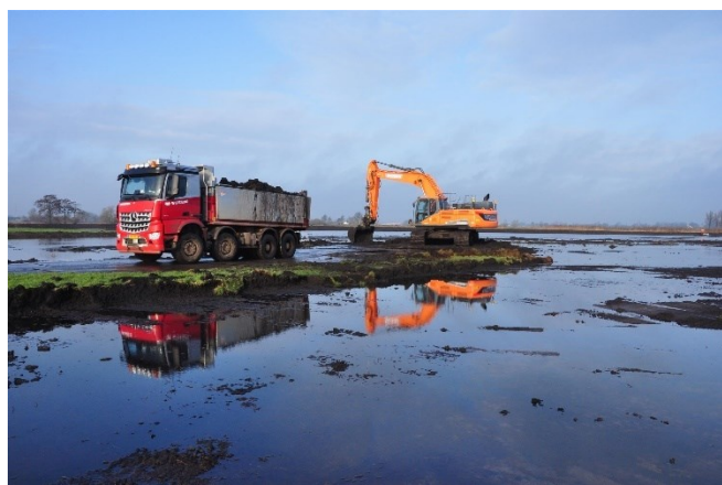
Foto: Graafmachines aan het werk in de Achterbergse Hooilanden.
