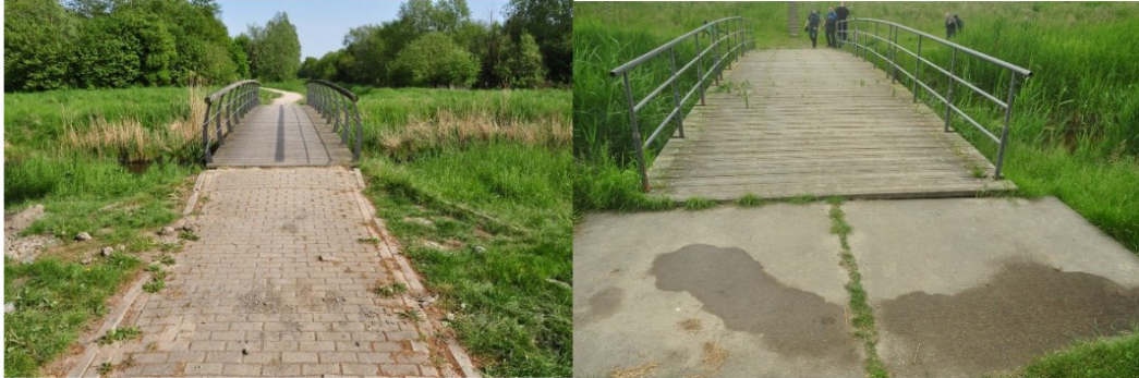
Hoogteverschil bij brug klinkers (Zwaansbroek) en betonplaten (Venneperhout)
