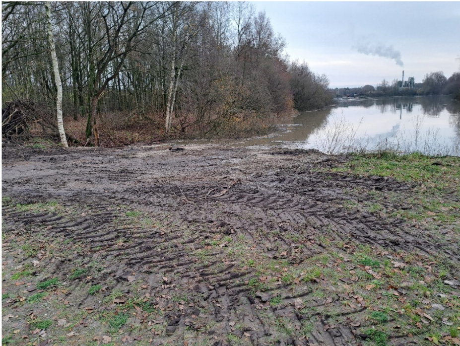
Zicht op de werklocatie van de dam (14 december 2023)
