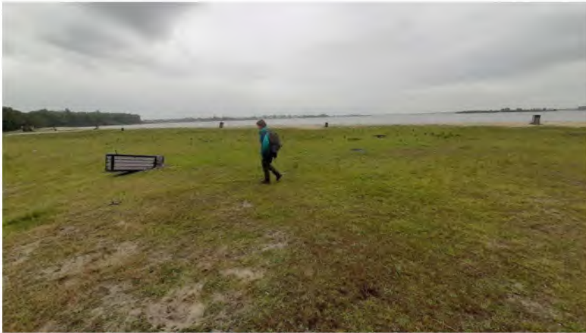
Figuur 6: Vandalisme en brandplekken Recreatiestrand
