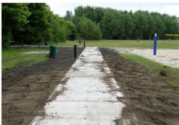
Betonplaten in verhoogd bed met 1 meter zwarte grond aan weerszijden (10 mei 2019)
