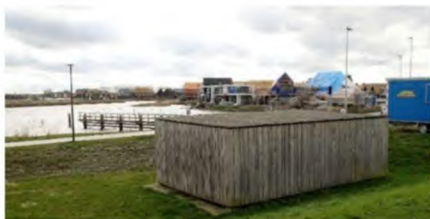
Houten schuur bij fietspad die gedeeltelijk is meegerekend ter saldering met oppervlakte van het NNN die verloren gaat.
