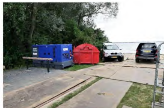
September 2019: generator t.b.v. mossel-evenement zeer dicht op het zuidelijke bosje geplaatst
