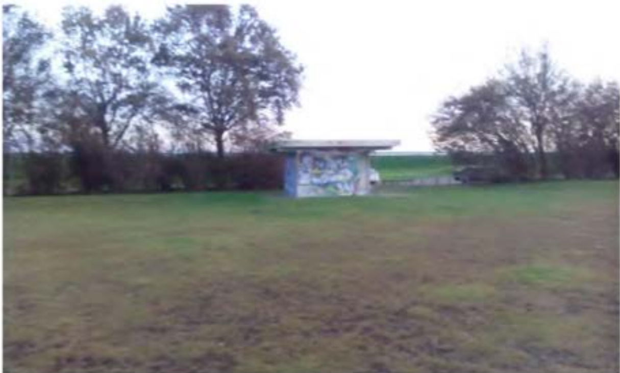
Foto van noordelijk toiletgebouw
