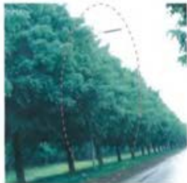
Bestaande mast op de Stichtseweg
