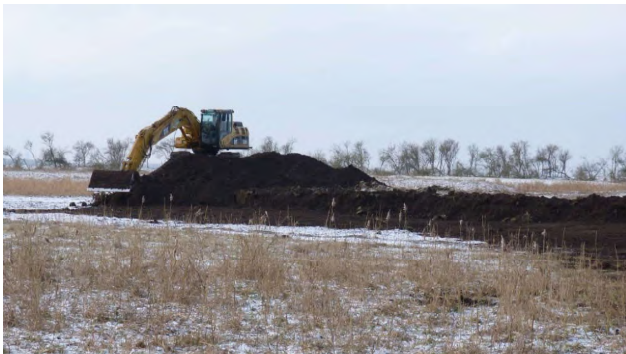
Werkzaamheden aanleg richels in de Oostvaardersplassen, 30 november 2010
