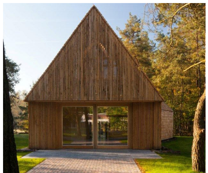
MENNORODE KERK, ELSPEET (FARO ARCHITECTEN)
