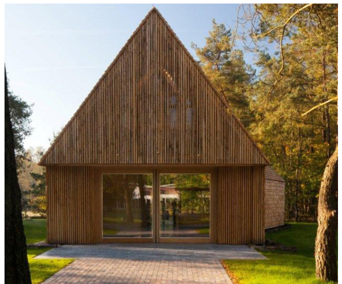
MENNORODE KERK, ELSPEET (FARO ARCHITECTEN)
