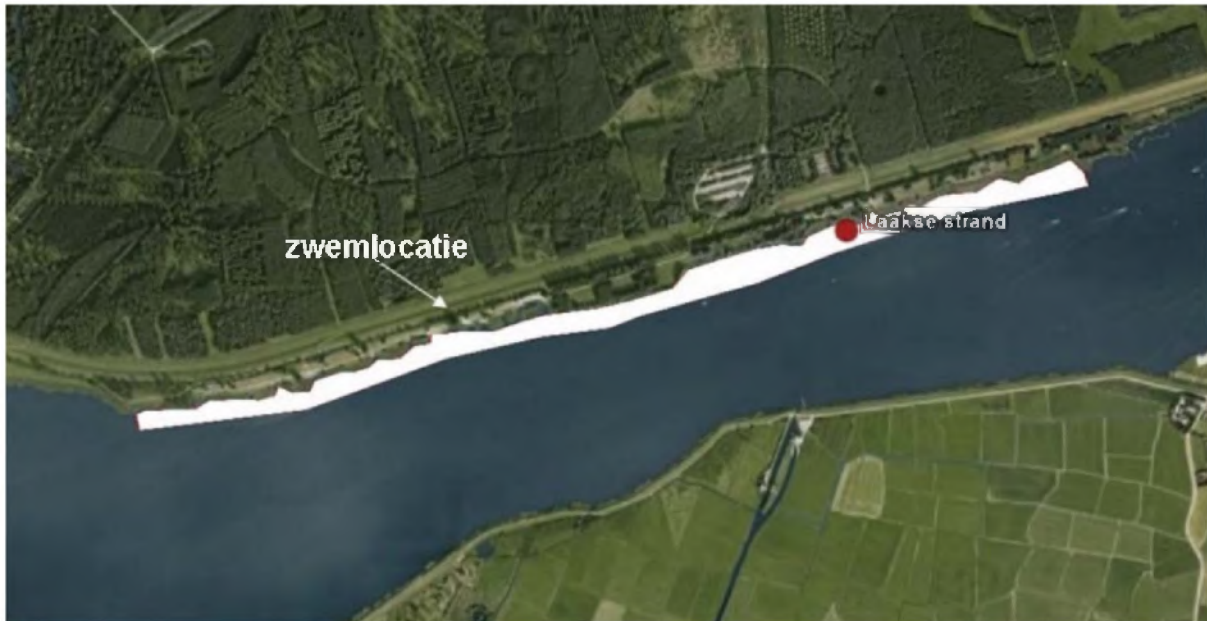
Figuur 3.3. Luchtfoto van de zwemwaterlocatie Laakse Strand met de zwemzone en het monsterpunt.
