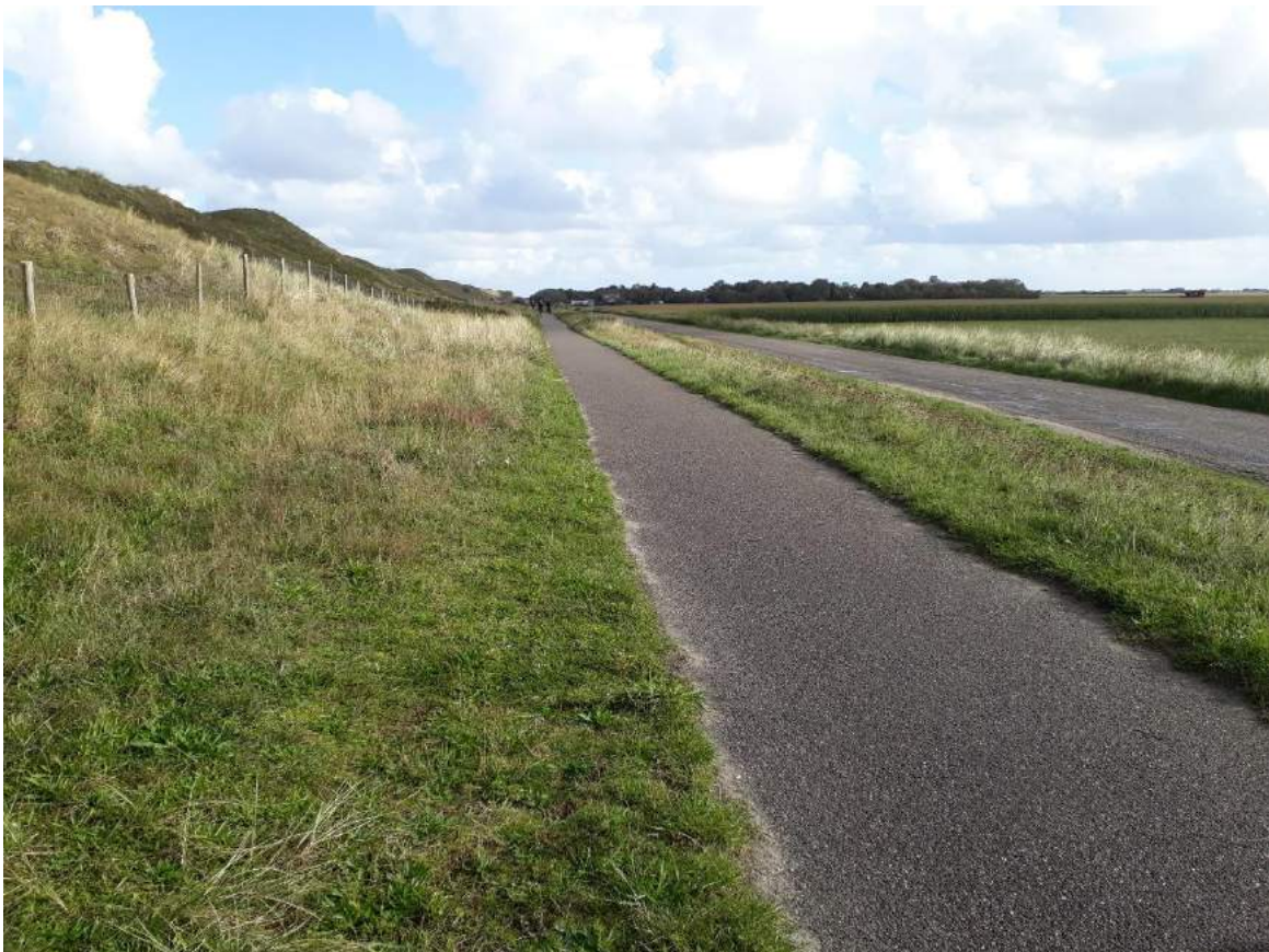
Fietspad met rechts de weg "Zanddijk"
