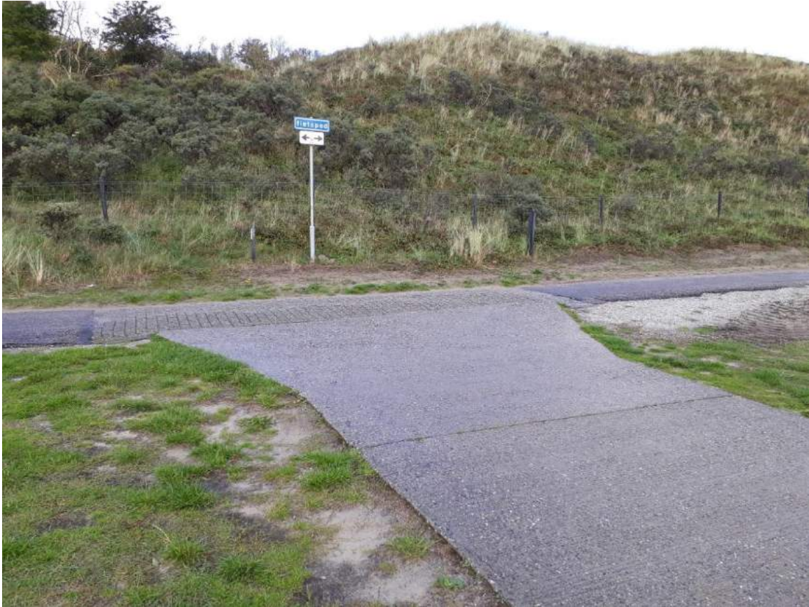
Aansluiting met fietspad Hanenplas
