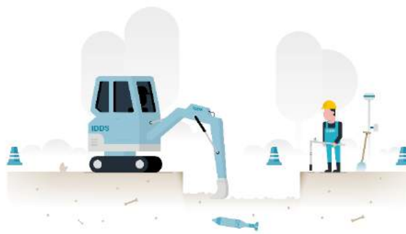
Figuur 5: Het benaderen van significante objecten met inzet van een beveiligde kraan
