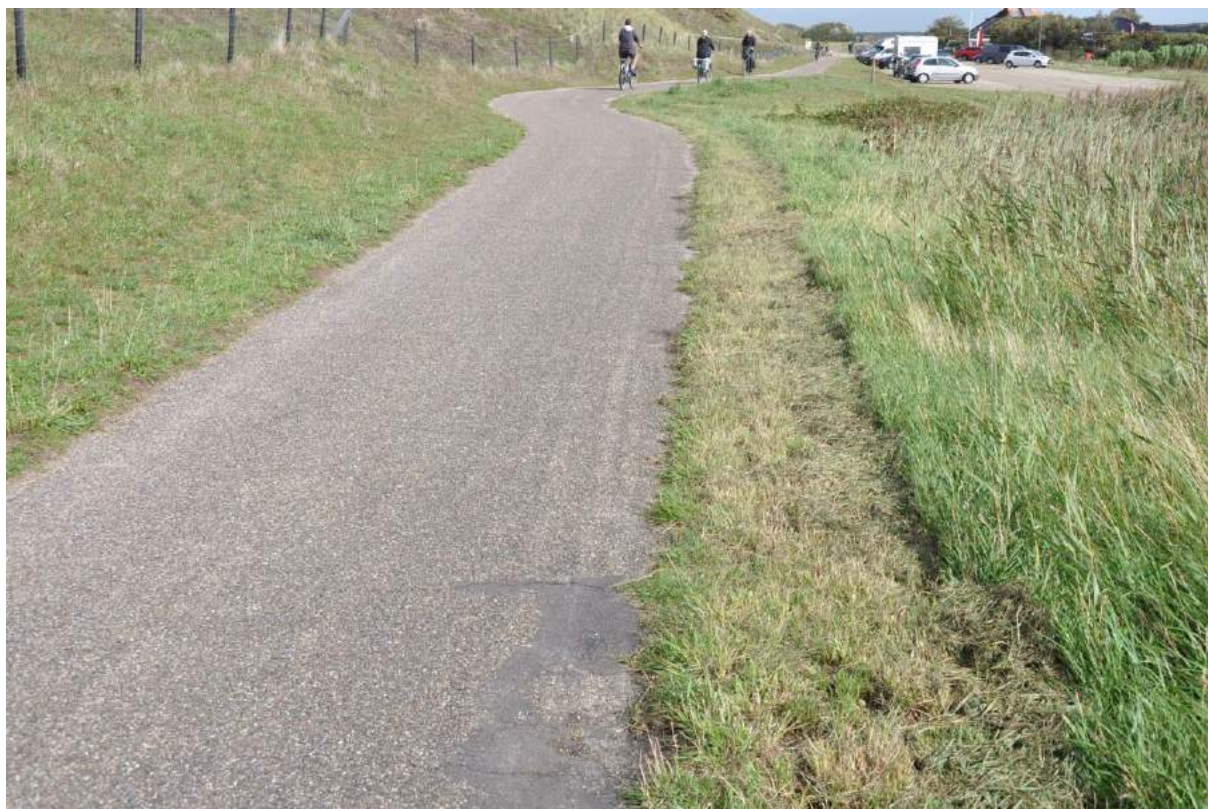
Figuur 8. Voorbeeld van geklepelde berm
