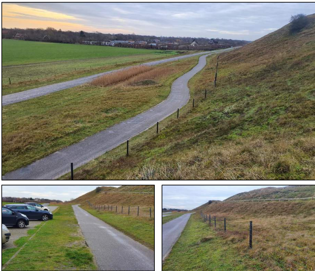
Figuur 3: Huidige situatie plangebied. Foto's genomen ter hoogte van het parkeerterrein van restaurant de Slufter.
