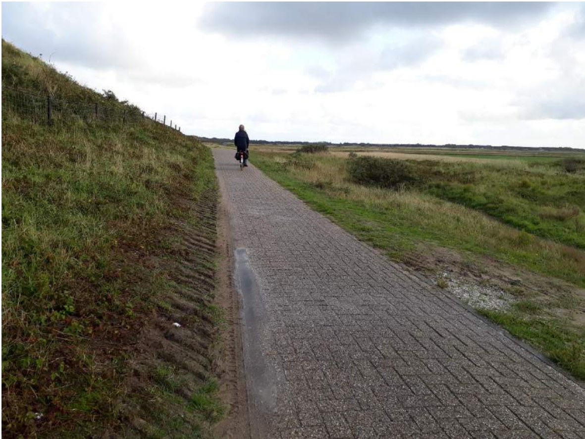
Asfalt is deels vervangen door klinkerverharding
