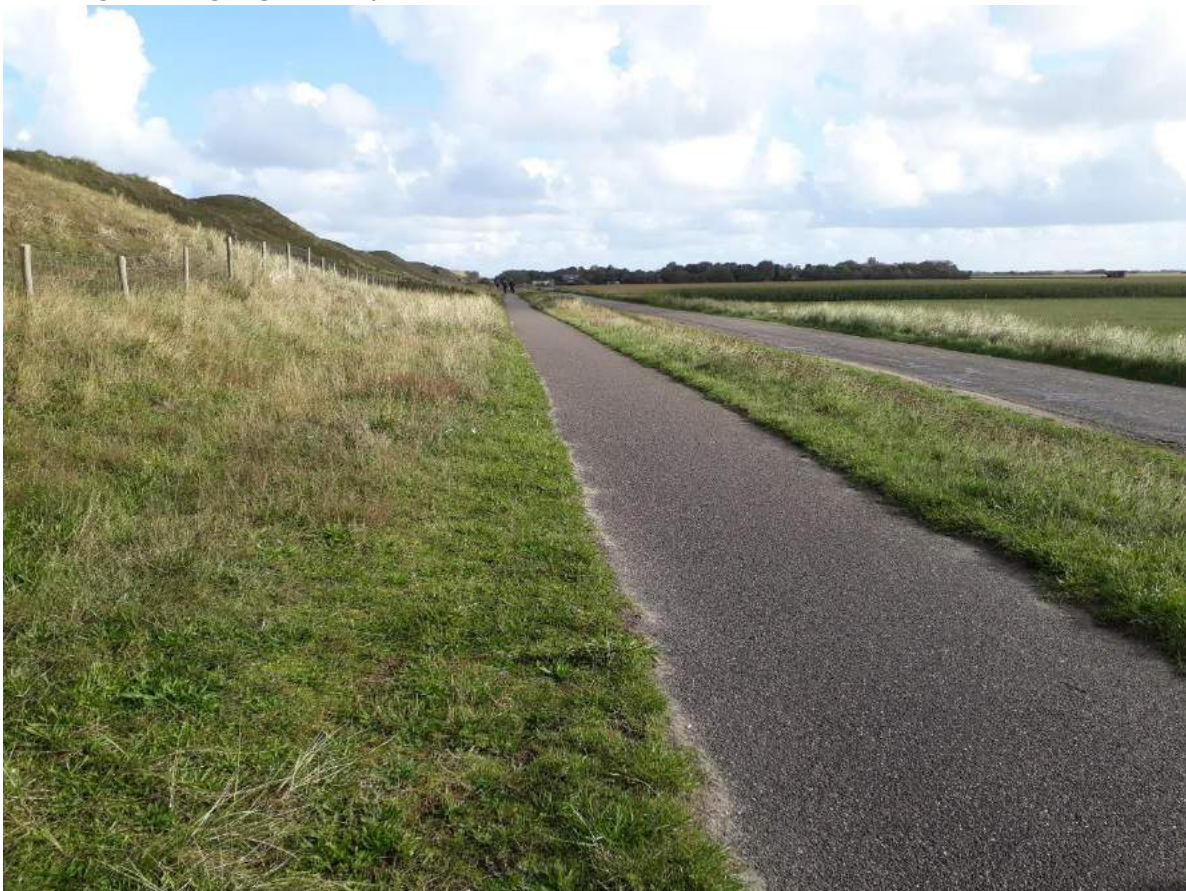
Fietspad met rechts de weg "Zanddijk"
