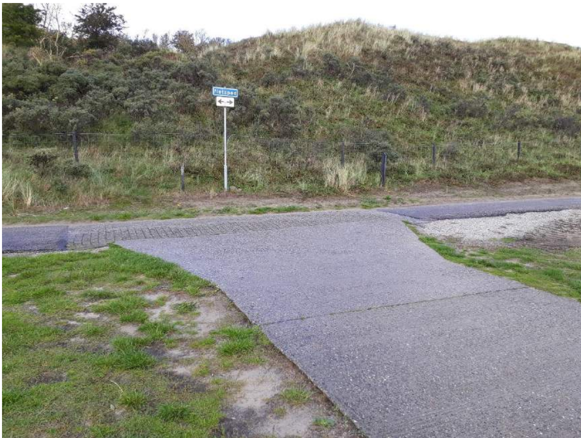
Aansluiting met fietspad Hanenplas
