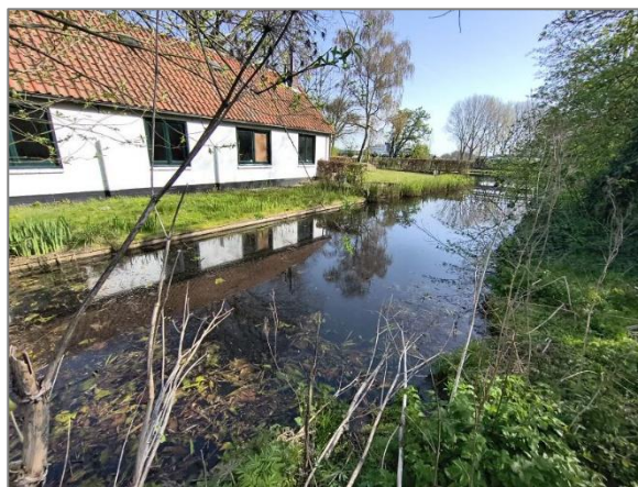
Afbeelding 1.8 | Watergang bij de zuidgevel van het gebouw.
