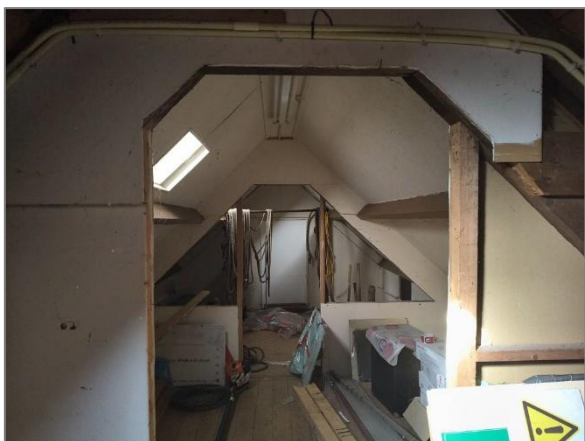
Afbeelding 1.3 | Zolderruimte van het gebouw.
