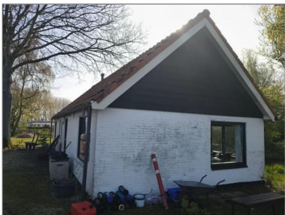
Afbeelding 1.1 | Westzijde van het gebouw.
