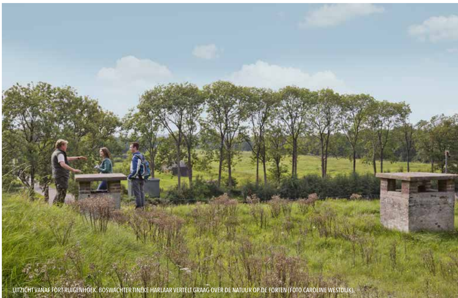
INFANTERIESTELLING WERK AAN DE GROENEWEG, AANGELEGD TER VERDEDIGING VAN HET FORT BIJ HONSWIJK, IS OP BASIS VAN OUDE TEKENINGEN EN HISTORISCHE LUCHTFOTO'S NAAR OORSPRONKELIJK MODEL HERSTELD EN VOOR PUBLIEK TOEGANKELIJK (FOTO HANS VAN DEN BOS).
