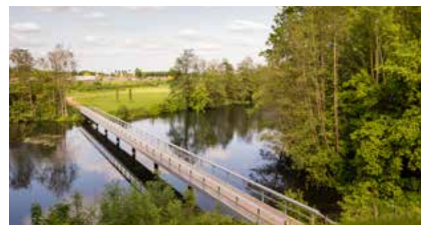
BRUG BIJ HET WATERLINIE-MUSEUM (FOTO WATERLINIE-MUSEUM FORT BIJ VECHTEN, MARCEL KOPPEN).
